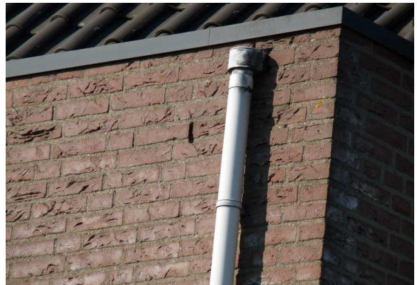
Figuur 18. Het te verbouwen deel van de AH-winkel bevat op meerdere plekken open stootvoegen.
