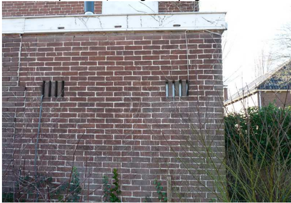
Figuur 15. De ventilaties in de muren van het te slopen deel van de kringloopwinkel zijn allemaal afgedicht.
