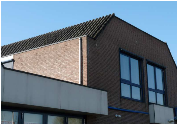
Figuur 17. Het te verbouwen deel van de AH-winkel bevat op meerdere plekken open stootvoegen.
