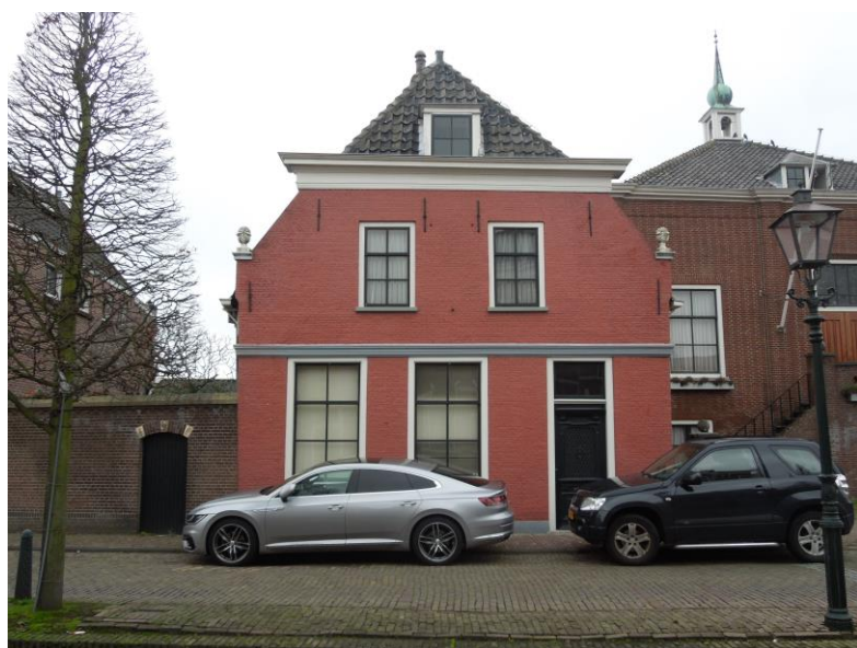
2 De voorgevel van 's-Herenstraat 15. Het metselwerk van de pui en de verdieping wordt van elkaar gescheiden door een geprofileerde, houten waterlijst. De voorgevel wordt aan de bovenzijde afgesloten met een houten hoofdgestel.
