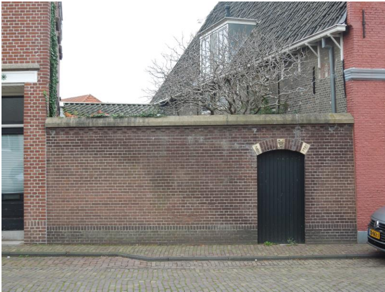
30 De negentiende-eeuwse tuinmuur tussen Huize Barendrecht (rechts) en 's-Herenstraat 14 (links). De muur is gemetseld in rode vormbakstenen in kruisverband en wordt aan de bovenzijde beëindigd met een bloktand, een rij strekken en een natuurstenen afdekplaat.
