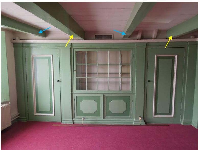
100 De kastenwand aan rechterzijde. Aan deze zijde is in het middelste vlak geen ellipsboog. De deurtjes en het venster met roedenverdeling voor de kast in het middelste vlak zijn pas in 1978 aangebracht, op foto's uit 1976 waren deze nog niet aanwezig (zie afb. 7 op p. 14). Ook zijn er aan weerszijden nieuwe deuren in de kastenwand geplaatst. De vormgeving van de kasten wijst op invloeden van Lodewijk XVI-stijl/ empirestijl. Deze bouw- en interieurstijl werd eind achttiende en begin negentiende eeuw toegepast. Het is niet duidelijk of de kastenwanden van origine op de verdieping stonden. Daarvoor zijn zij eigenlijk te rijk uitgevoerd.
