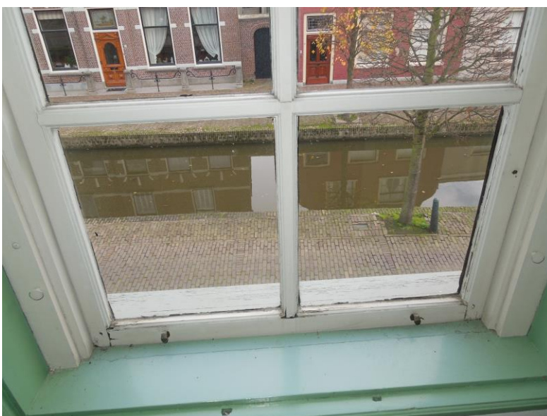
101 Eén van de twee zesruits schuifvensters in de voorgevel. De vensters zijn in 1978 aangebracht naar oud model. Voorafgaand aan de restauratie waren hier twee H-vensters.
