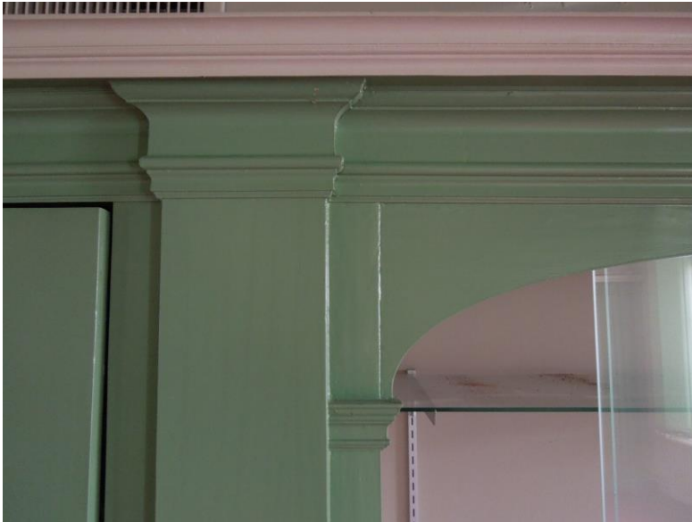
99 Detail van de bovenzijde van een van de pilasters. De kastenwand wordt aan de bovenzijde beëindigd met een kroonlijst.
