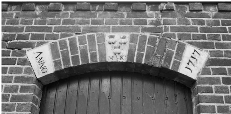
3 De boog van de tuinpoort met de hergebruikte natuurstenen aanzet- en sluitstenen uit 1717. In het midden het familiewapen van de familie Knol met daaronder de initialen ‘M’ en ‘K’.
