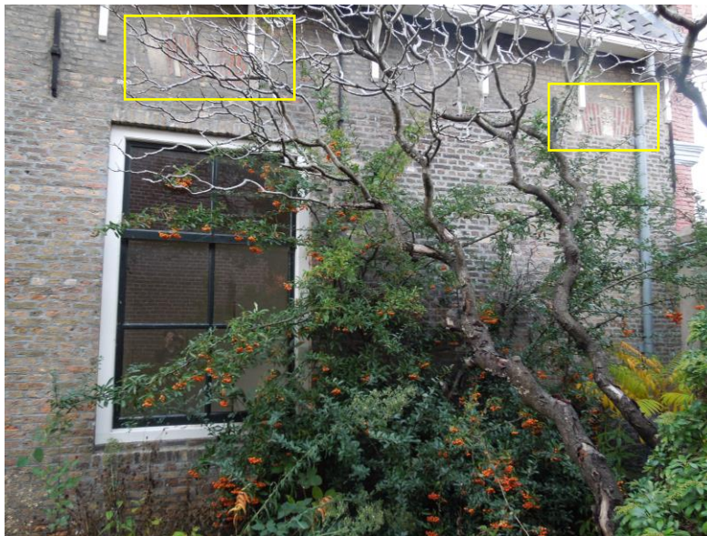
17 Het voorste deel van de linker zijgevel, gezien vanuit de tuin. De gevel is gemetseld in IJsselstenen in kruisverband. Het zesruits schuifvenster is aangebracht in 1978.
