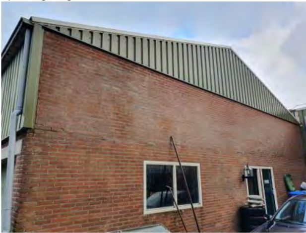
De gevel en het dak van de schuur is een gesloten geheel zonder openingen.
